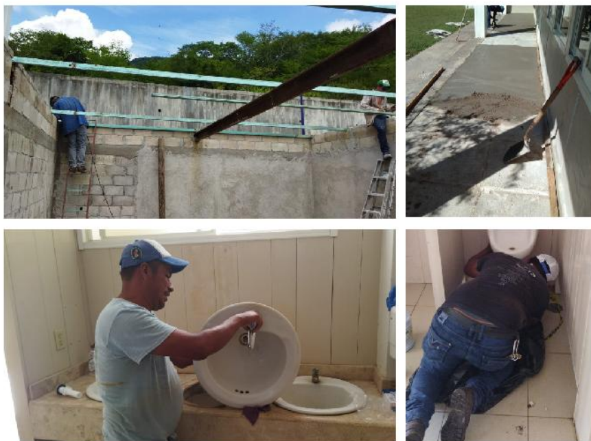
Figura 11. Mantenimiento, arreglo y construcción de infraestructura en la EEAM
